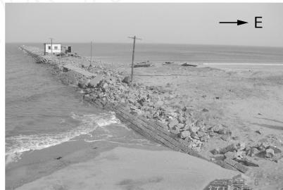
图5 西突堤两侧海滩的侵蚀与堆积
