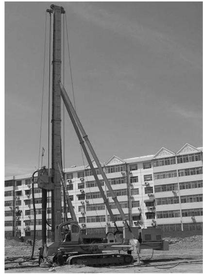
图4 螺杆桩钻机施工现场
