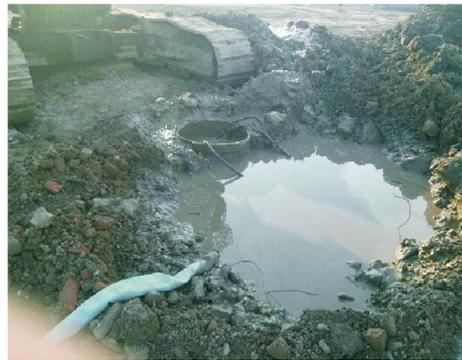
图4 孔口泥浆缓存围堰
