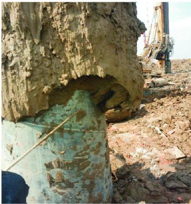
图3 护筒拔起后的外观
