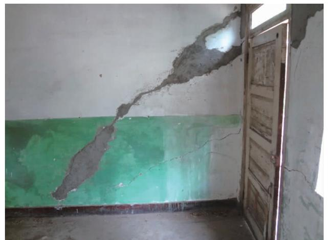
图 4 房屋墙体与台阶上分布的裂缝
