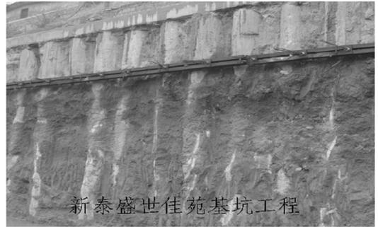
图 4 排桩挡土结构及摆喷帷幕
