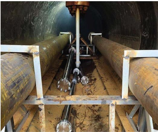
图 2 管道进舱和固定
