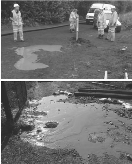
图 2 非开挖 HDD“溢浆”现象
